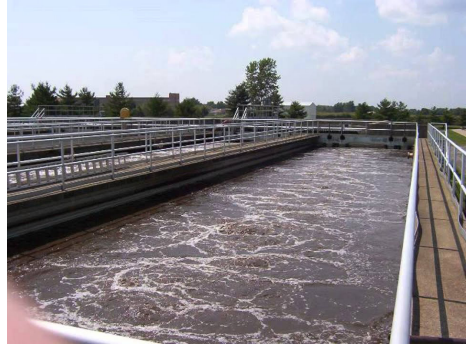
บ่อบำบัดน้ำเสีย
